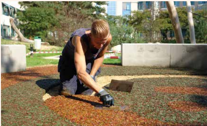
Het aanbrengen van een Tiger Mulch valondergrond
