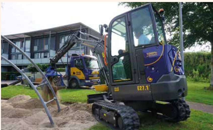
Het aanbrengen van een Tiger Mulch valondergrond
